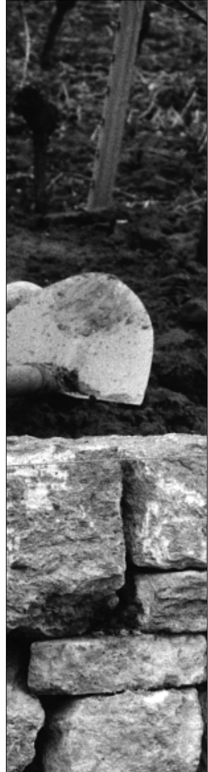
«Fotografie Trockenmauern», Stiftung Umwelt-Einsatz Schweiz
